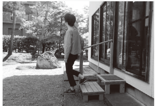
お庭に続く階段を二か所に設置しました
