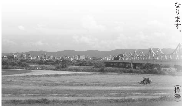
現在の長生橋は昭和12年に架け替えられたもの。13の山型が連なる形状が美しいゲルバー式鋼構橋。
